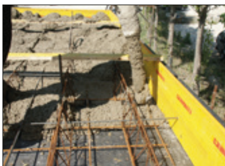
⑤ CONCRETE POUR
