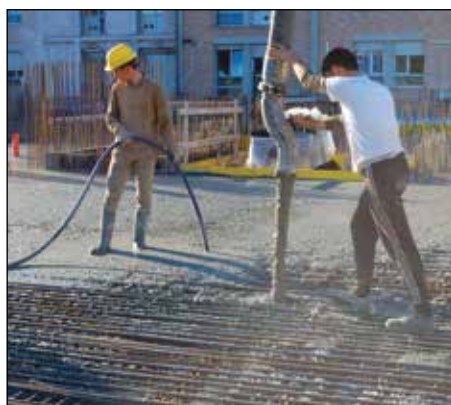
⑦ ВТОРАЯ ЗАЛЫВКА БЕТОНА
