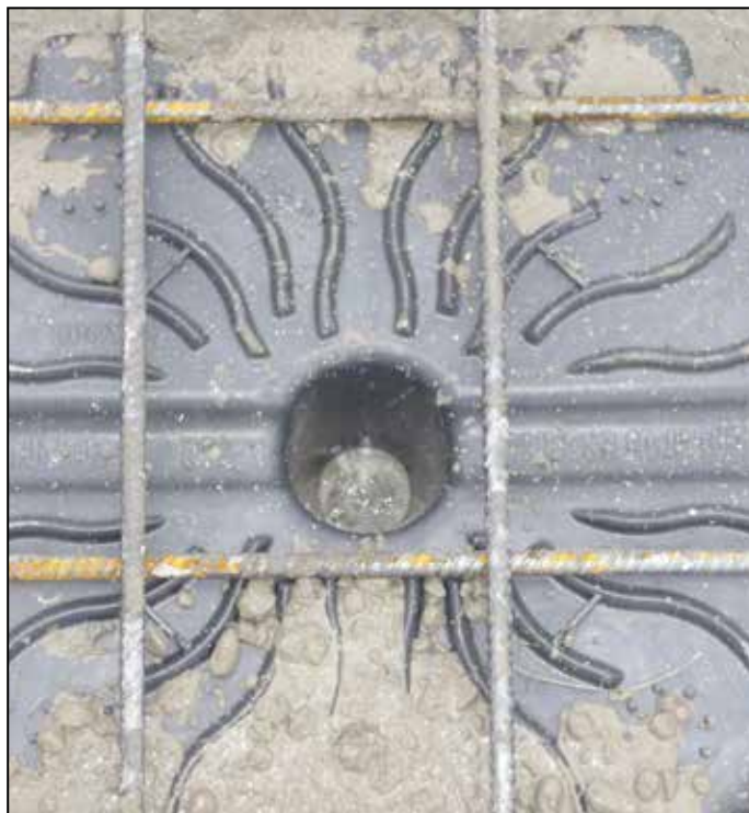
Визуальная контроль завершения бетонирования нижней плиты
