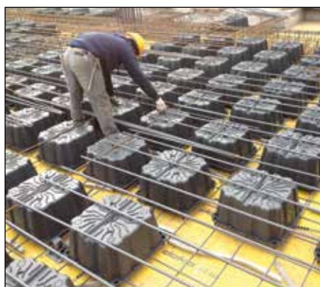
④ ЗАВЕРШЕНИЕ УКЛАДКИ АРМАТУРЫ
