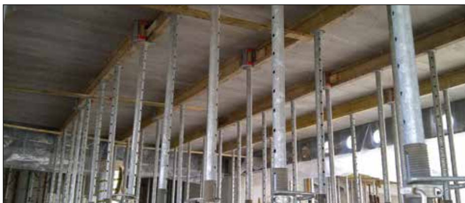
⑧ СНЯТИЕ ОПАЛУБОК
