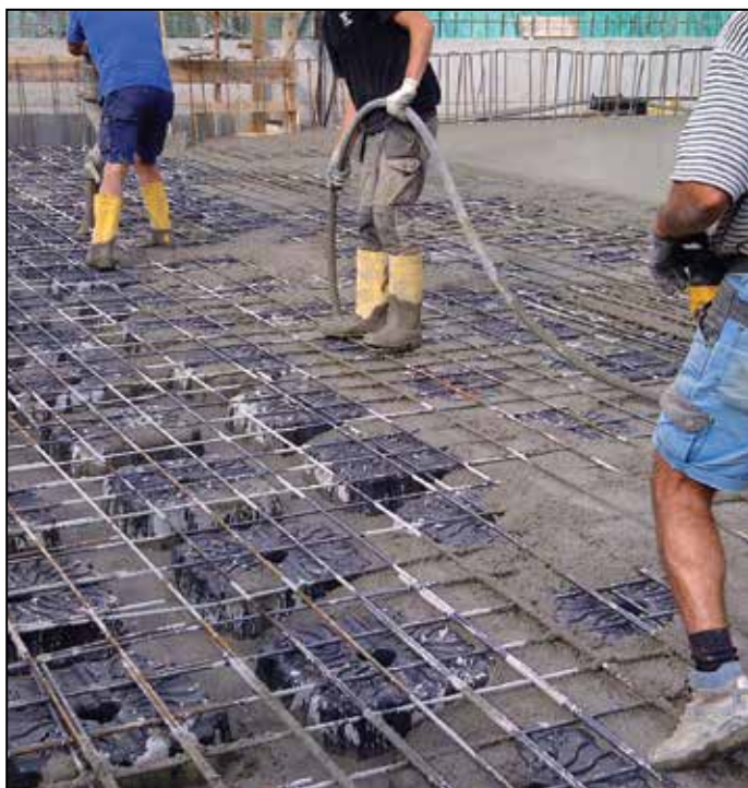
Выполнение бетонирования на 2 последовательные фазы (не более чем 1 час между ними)
