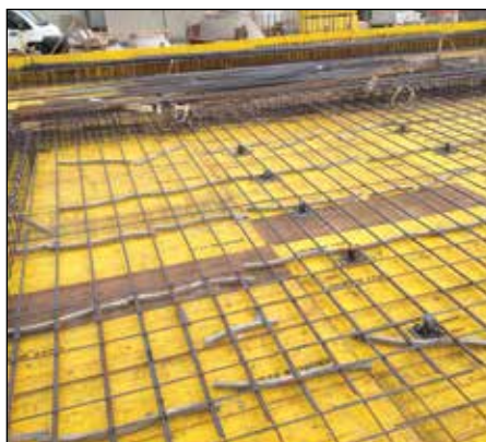
② УКЛАДКА НИЖНОЙ АРМАТУРЫ И ПОЛНЫХ ЗОН
