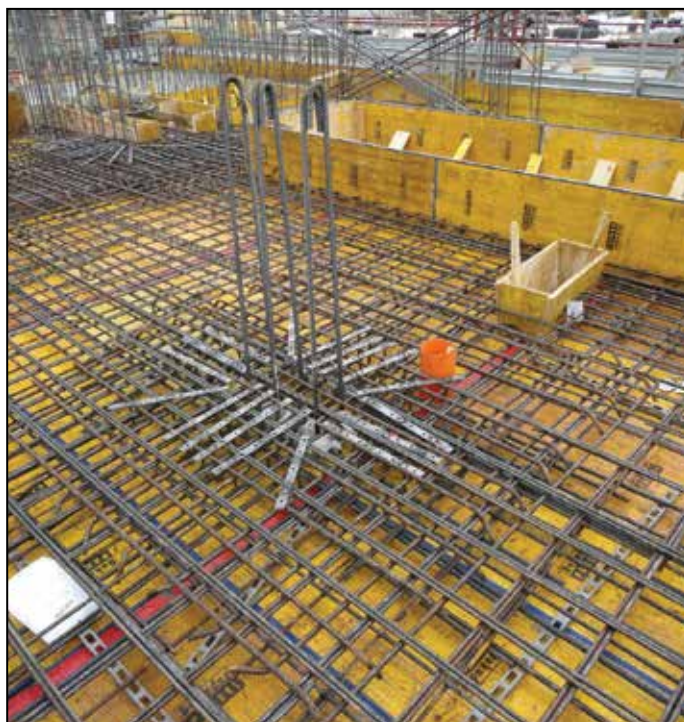
Специальная арматура и пробивание отверстий в колоннах
